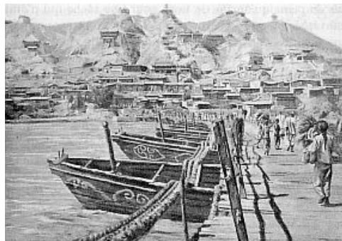
Pont de Lan-Tcheou
