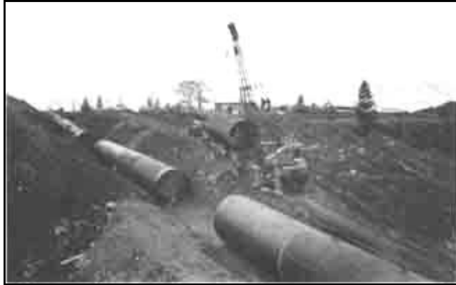
Fig. p. 99b. La mise en place de l'amenée d'eau alimentant la centrale hydroélectrique de la compagnie. Source : La Pulperie de Chicoutimi.
