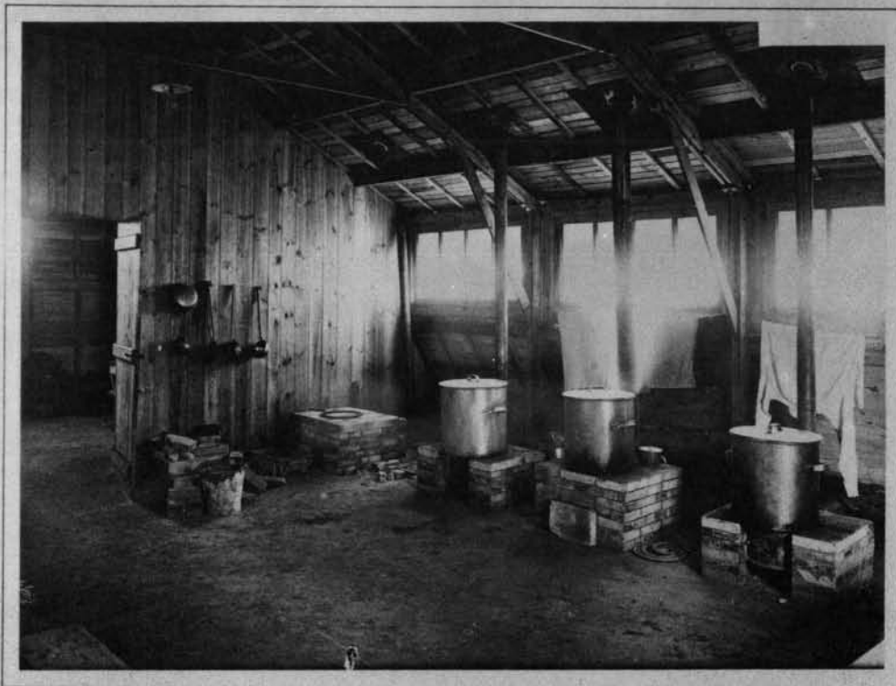
Logement du personnel nuit. Cuisine avec intérêt.
