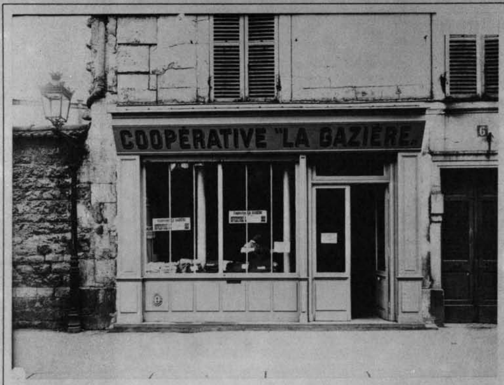
Coopérative "La Gazière" Magasin 6, rue des Branchements. Vue extérieure.
