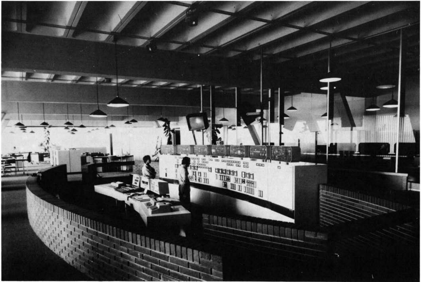
Salle de contrôle "Ciments Lafarge". 1971. Studio Henry.
