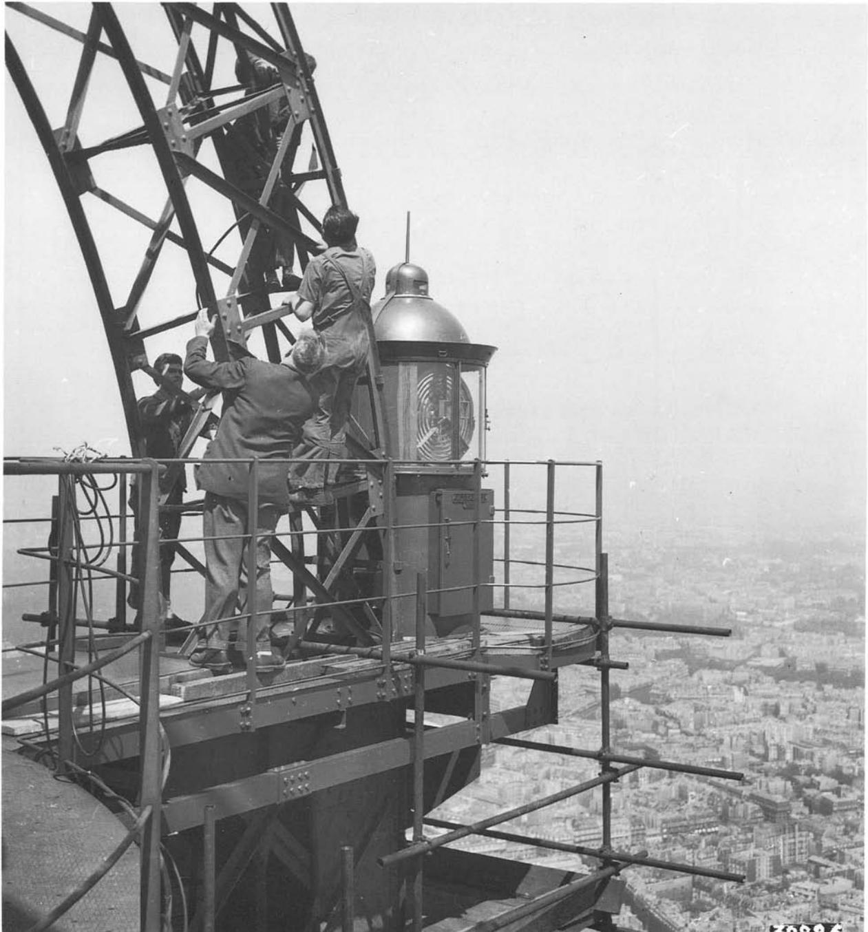
Fig. 12 Soudure exécutée à l'aide d'un transformateur TST 150 (1949).
