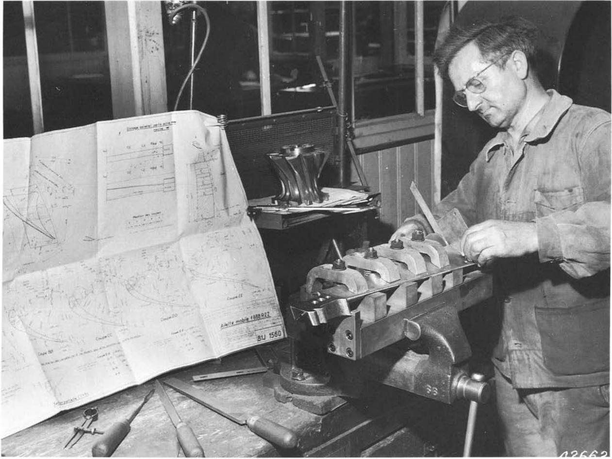
Fig. 18 Montage du cylindre BP d'un groupe turbo-alternateur 125 MW N° 4 à la centrale Emile Huchet, en 1959.
