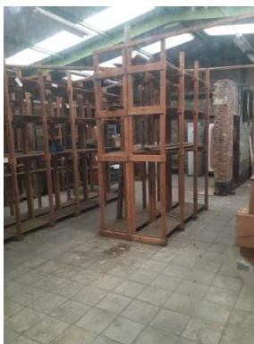
Figure 10 (à gauche) : Racks de rangement dans un hangar en démolition à proximité de la friche, La Louvière, 2018. ©L'OCCAUX21 UMONS.
