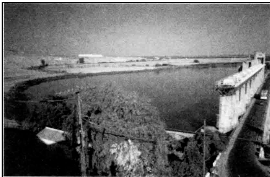
Illustration 3 Barrage sur le Guadalquivir près de Alcalá del Rio
